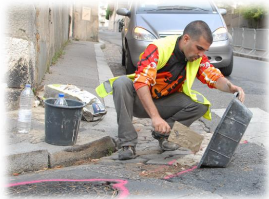
letzte Vorbereitungen zur Sanierung der Rennpiste
